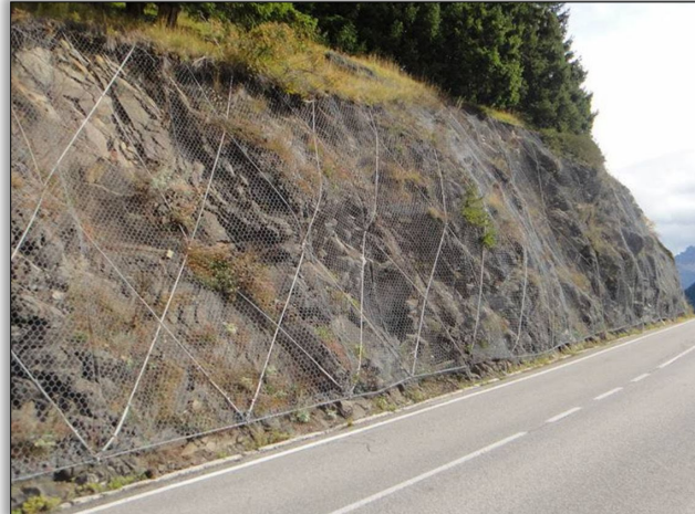
Objetos para la prevención de la caída de rocas
