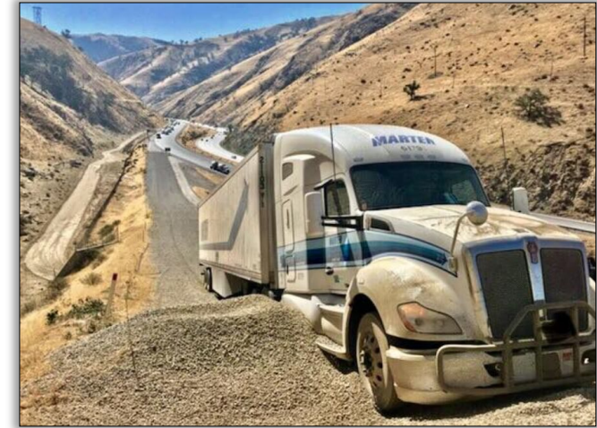
Rampa para camiones fuera de control
