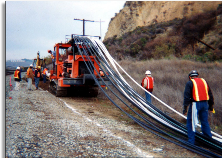
Infraestructura de Comunicación por Fibra
